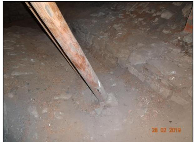
**Empfehlung:** Die Zugänge und die Arbeitsebenen müssen ausreichend tragfähig hergestellt und gegen Absturz gesichert werden. Die Dielenstärke muss so dimensioniert sein (mind. 50 mm), dass abgeschlagene Glockenteile, gelöste oder gebrochene Klöppel können den Boden nicht durchschlagen, auf Verkehrswege fallen und Personen verletzen können.
